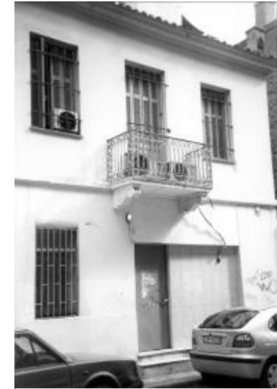
εικόνα β.1. Σφραγισμένα παράθυρα, αναμμένο φανάρι και στρώση με πλακάκι στον τοίχο δίπλα από τη μεταλλική είσοδο.
