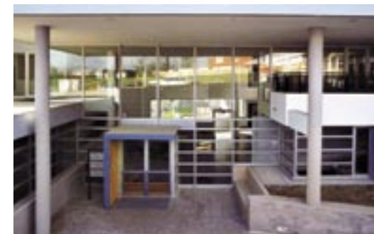
Εικ. 21 Εξωτερική άποψη του Νηπιαγωγείου στη Marne-la-Vallée, Γαλλία, 1986. Αρχιτέκτων Henri Ciriani. Διαφάνεια μεταξύ της εισόδου, του εσωτερικού χώρου υποδοχής και του κήπου-παιχνιδότοπου
