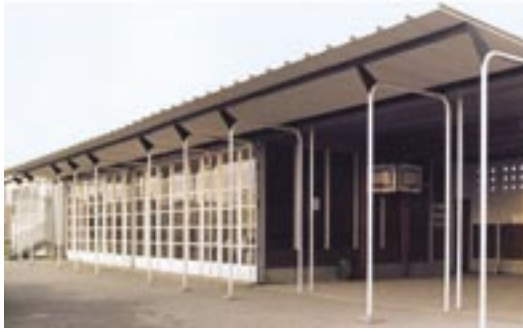
Εικ. 7 Προκατασκευασμένο σχολείο στο Vantoux, Γαλλία. 1950. Αρχιτέκτων-μηχανικός Jean Prouvé
